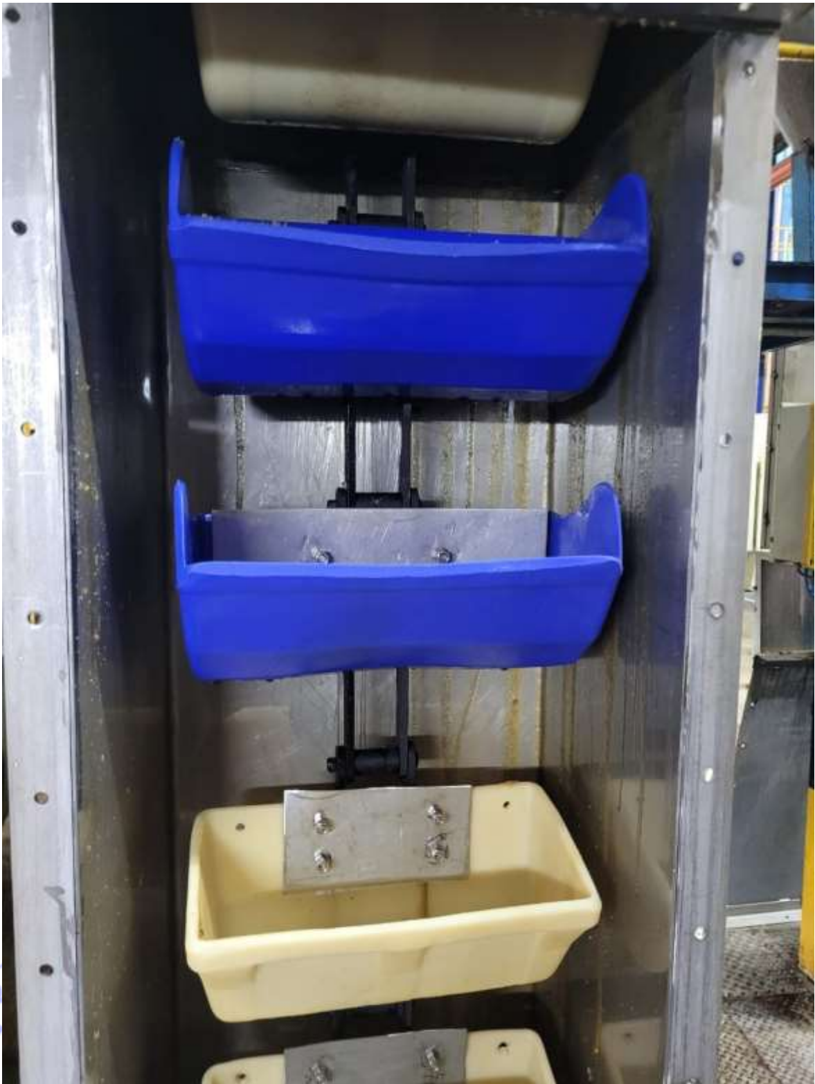
Anexo 8. Elevador de azúcar limpio cambio de cangilones
