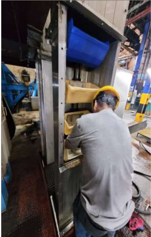
Anexo 12. Elevador de azúcar en mantenimiento.
